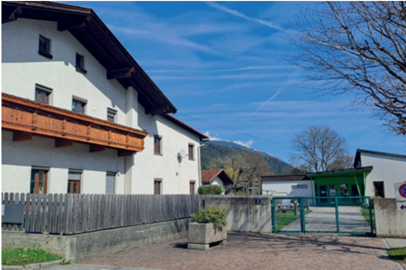
JAM lädt ins Erdgeschoss des hinteren Teils von Oberdorf 6 ein.
